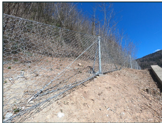
Interventi nella zona di transito e/o di arresto (interventi passivi)
