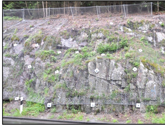
Interventi nella zona di distacco o di instabilità
